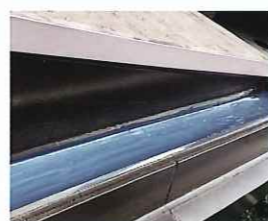
箱樋の補修に
